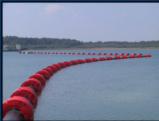
Schwimmrohrleitung aus PE-HD
